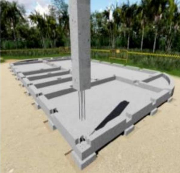
Figura 43 - Encaixe dos pilares
